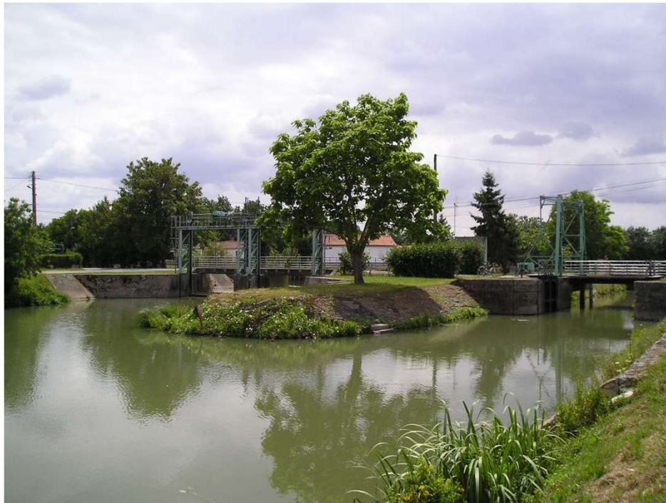
Les barrages-écluses de Bazouin, à la limite entre Vendée, Deux-Sèvres et Charente-Maritime.
