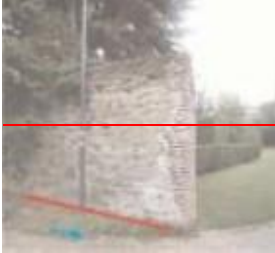
Mur (AIVF_20_5) (© Ville de Rennes)
