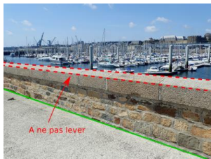
( © Brest métropole) Parapet (AIVF_2_5) (© C. Maury)
