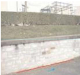
Mur de soutènement (AIVF_20_4) (© Ville de Rennes)
