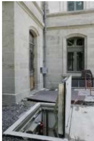
Poste de transformation cabine haute
