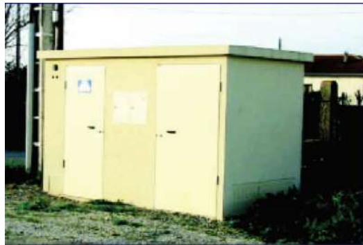
Poste de transformation enterré
