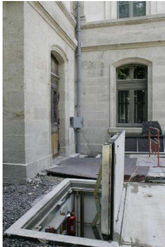
Poste de transformation cabine haute
