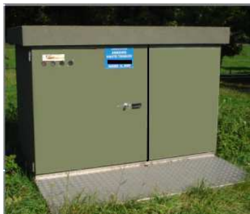
Armoire de coupure
