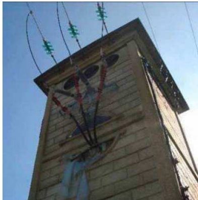
Poste de transformation cabine haute
