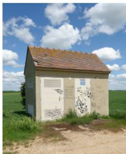
Les postes de transformation électrique suffisamment grands
