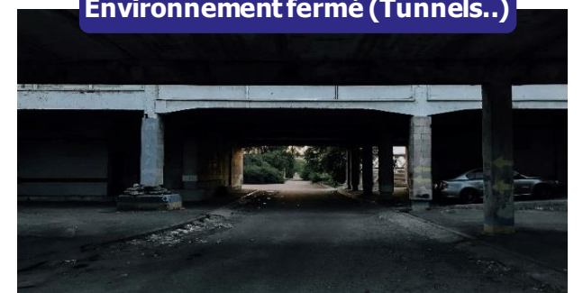
Environnement fermé (Tunnels..)
